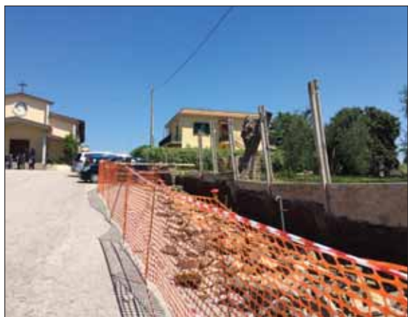
Muro in rifacimento del piazzale della parrocchia di San Giuseppe in Casalazzara
